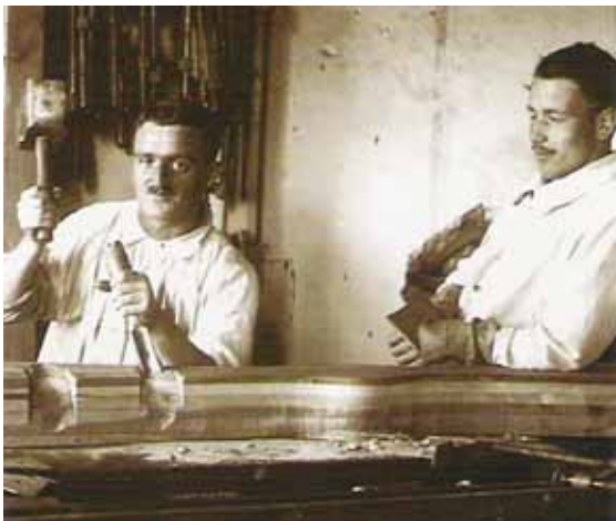
Propellerbau. Das Herausarbeiten des Profils.
