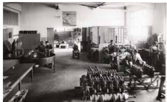
Revisionsarbeiten an Argus II (Wild WT1) und Hispano HS41(DH3).
