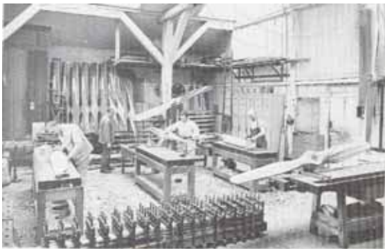
Propellerbau für den DH5.
