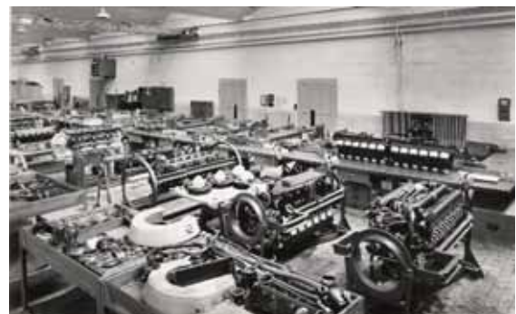
Revisionen an: vorn RR V-1650 (Mustang), hinten HS 51 ( Morane D3801 und C36).
