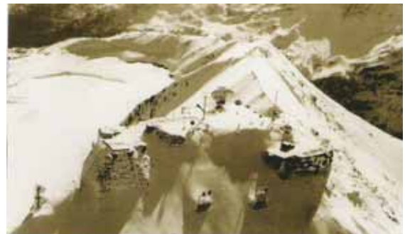
Eine Radar-Station SFR auf einem unserer Radar- berge.
