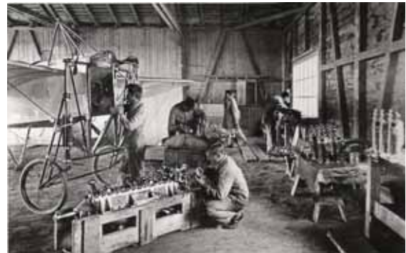
Motorenwerkstatt ca. 1917. Hier arbeiten die Mechaniker an einem Argus-Motor und an einem Blériot.
