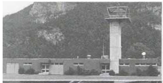
Meiringen heute: Im Turm ist die modernste Elektronik installiert.
